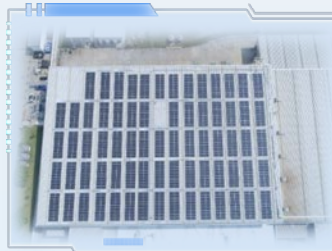
● Y Ogura ESIE, Rayong Capacity 0.5 MW
